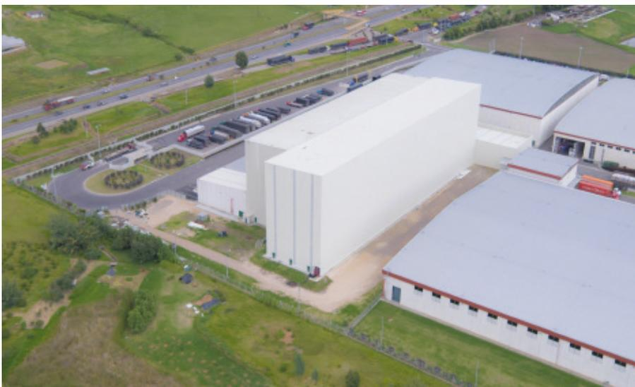
Grupo Familia, eine auf Pflege-, Hygiene- und Toilettenartikel spezialisierte Firma, verfügt über ein 35 m hohes automatisches, selbsttragendes Lager, das ca. 17.000 Paletten aufnehmen kann. Zur Lieferung von Mecalux für das Lager, das sich in Cajicá in Kolumbien befindet, gehören ebenfalls die Lagerverwaltungssoftware Easy WMS von Mecalux und das Steuerungsprogramm Galileo, das die mit dem Logistikprozess verbundenen Bewegungen steuert und ausführt.
