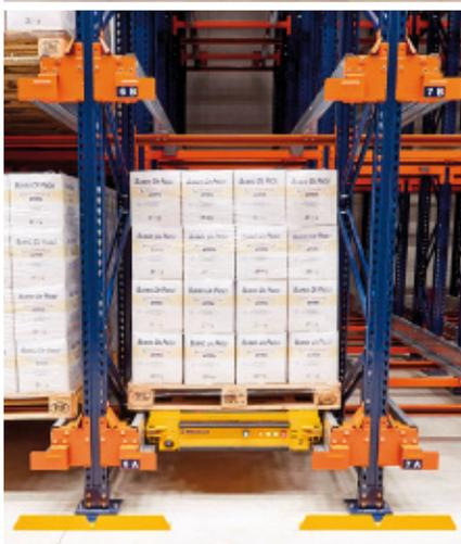
Der Butterhersteller Burro De Paoli hat seine beiden Tiefkühlager in Italien mit dem halbautomatischen Pallet-Shuttle-System ausgestattet. Die installierte Lagerlösung sorgt für eine Verbesserung der Produktivität, ermöglicht die Lagerung von 1494 Paletten und verringert die Zahl der benötigten Arbeitskräfte.
