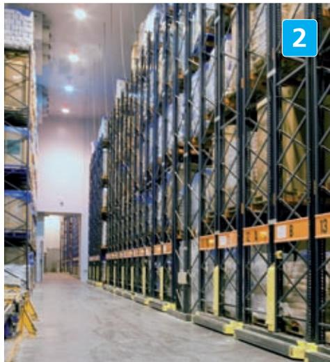
In den Regalen Verfahrwagen werden Produkte mit einem mittleren Umschlag und Paletten mit unterschiedlichen Abmessungen gelagert.
