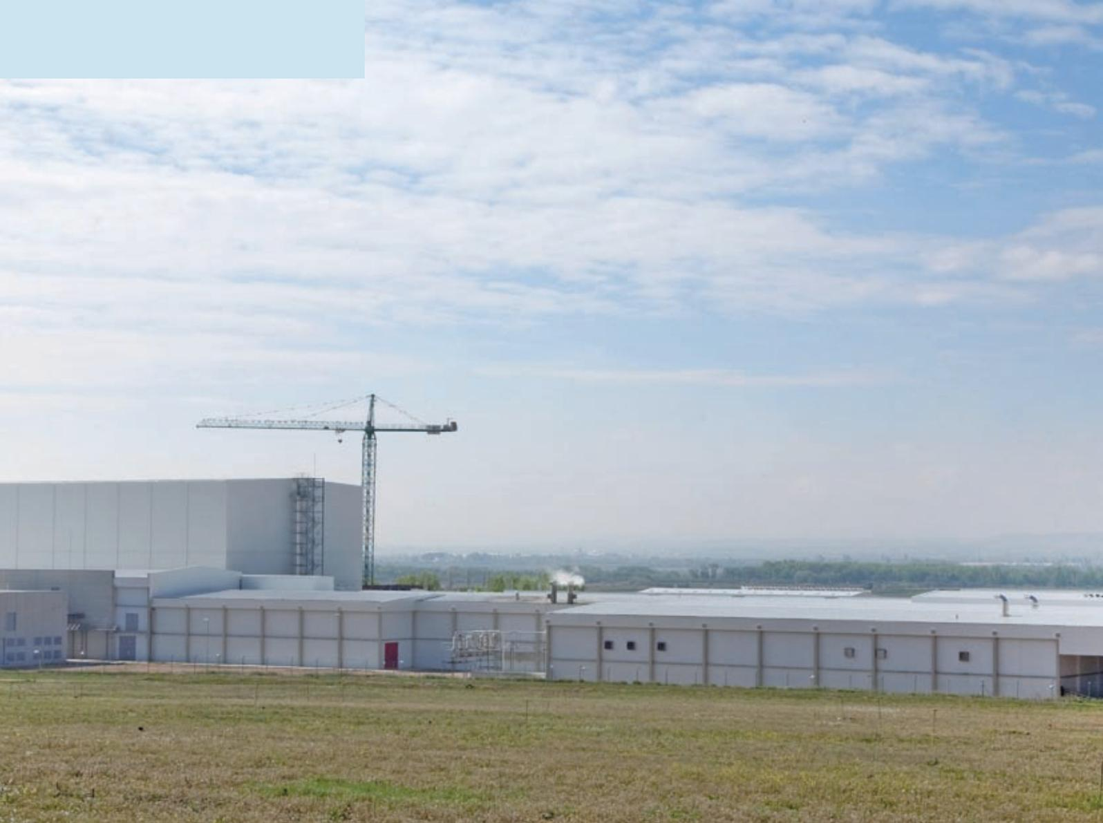
Die Bauweise ist sehr einfach. Auf einem Betonfundament mit ausreichender Isolierung und Tragkraft werden die Rahmen der Regale verankert. Danach werden vorgefertigte Module mit großer Höhe und unterschiedlicher Festigkeit montiert. Auf und um diese Struktur herum werden das Dach und die Fassadenprofile, auf denen später die Isolationsplatten angebracht werden, montiert.
